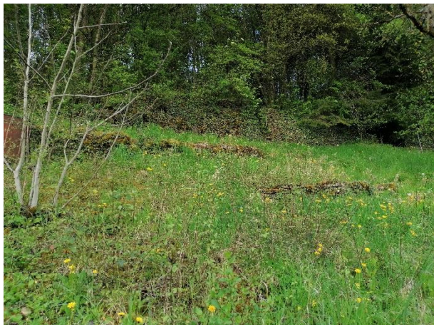
Illustration 14 – mur de soutènement en amont
