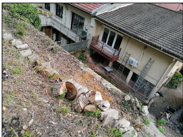
Illustration 11 – vue du dessus du mur de soutènement
