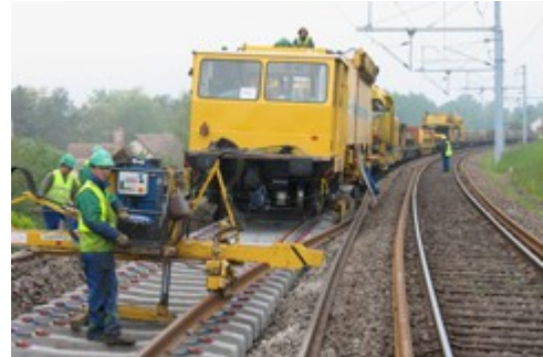
Rails longs soudés sur traverses béton
