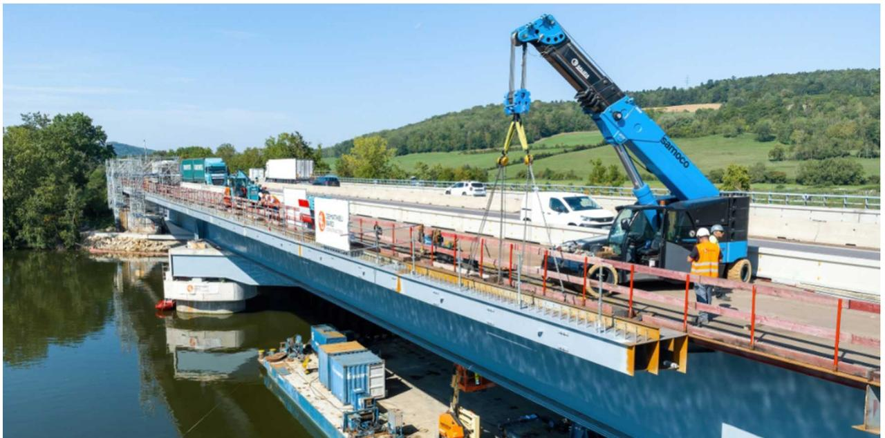
Le découpage des rives existantes et leur remplacement ont débuté en début d'année 2023, et vont se poursuivre jusque février 2024. Ces travaux nécessitent une **neutralisation des bandes d'arrêt d'urgence** et **l'abaissement de la vitesse à 90km/h** et **ponctuellement à 70km/h** pour des opérations de soudage spécifiques.
