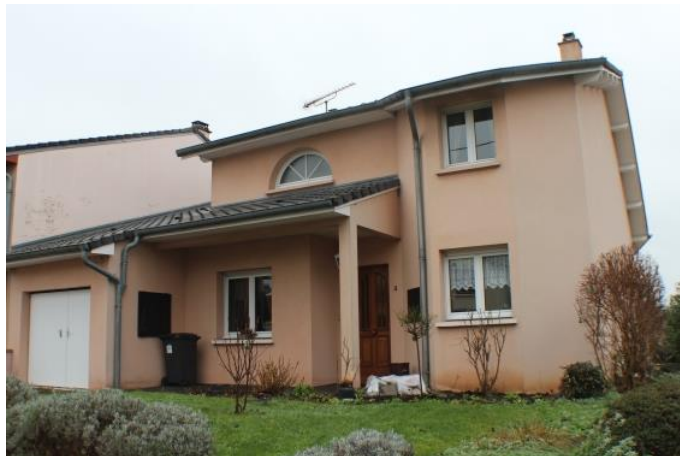
Figure 3.14 : exemples d'une irrégularité engendrée par une différence de hauteurs de deux corps de bâtiment
