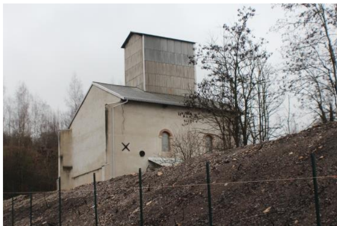
Figure 3.24 : exemples de mauvais état de conservation visibles de l'extérieur
