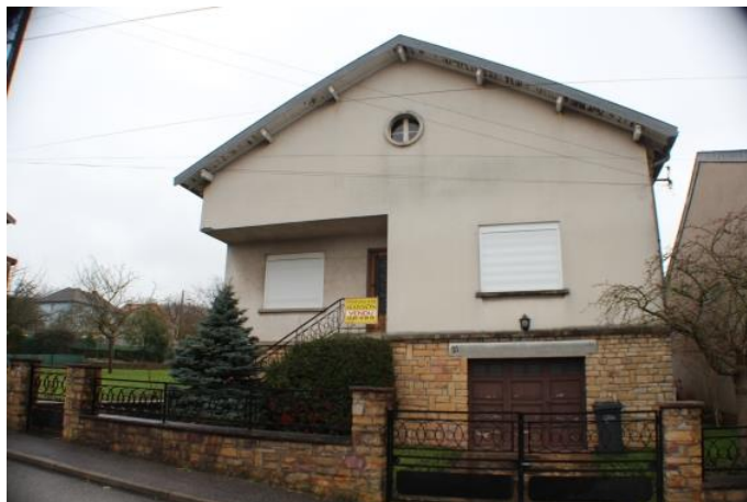
Figure 3.15 : exemple d'une irrégularité engendrée par un porte-à-faux
